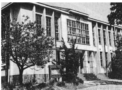
昭和24年10月 復旧竣工
