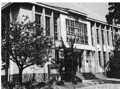
昭和24年10月 復旧竣工
