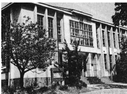
昭和24年10月 復旧竣工
