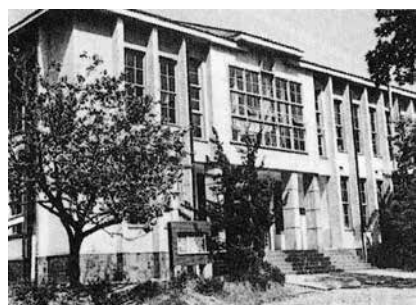
昭和24年10月 復旧竣工
