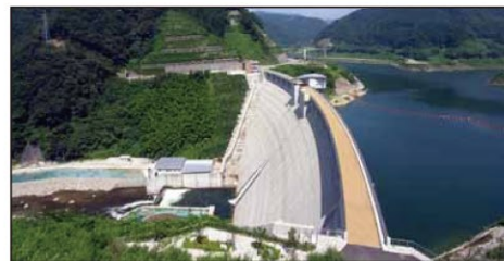
九谷ダム (平成17年度竣工)
